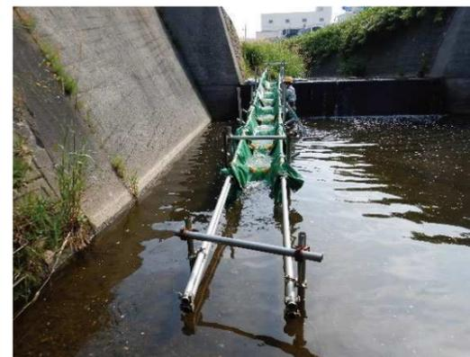
写真1 望月寒川1号床止に設置された布式魚道
